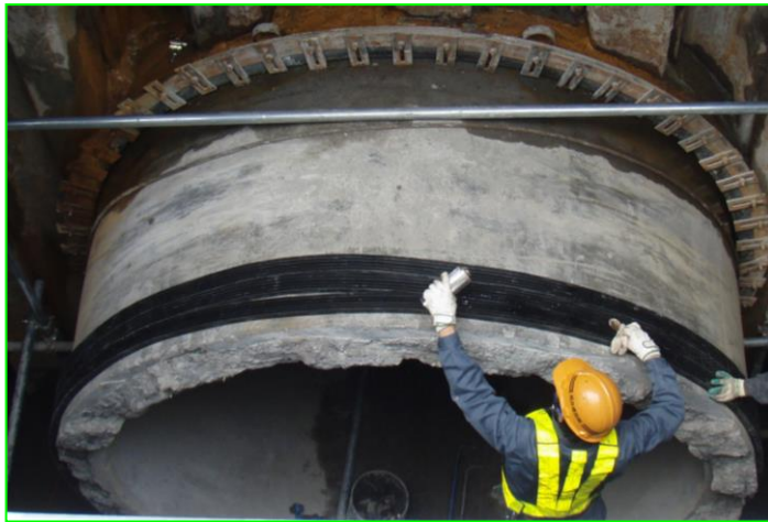
継手ゴムに滑材を塗布
