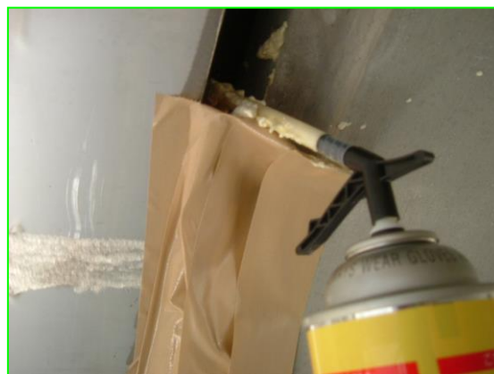
ガムテープを使用しての上部充填状況
